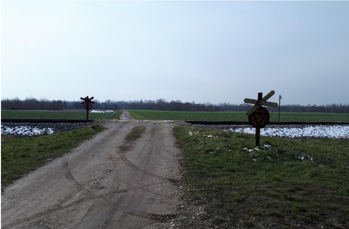
Slika. NPr Središče 1 v km 49+133 glavne železniške proge št. 44 Ormož–Središče–d.m.
